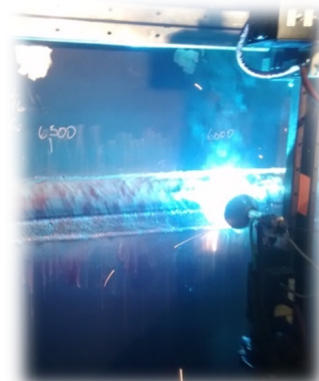
Figura: Reparación de Cladding
