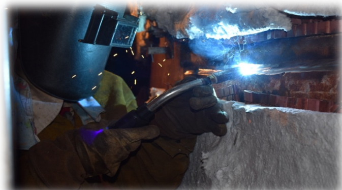
Figura: Reparación de Grietas Circunferenciales
