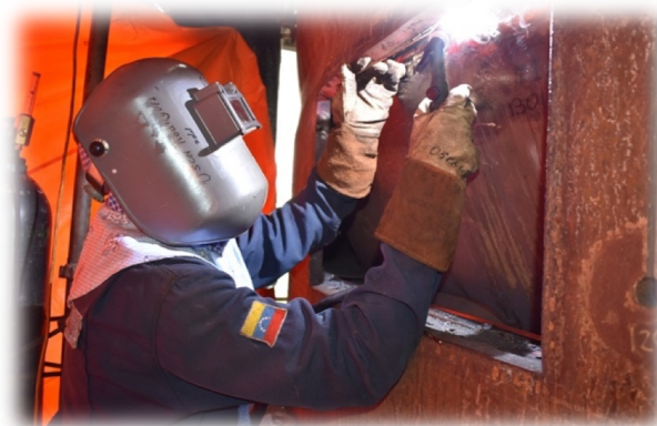
Figura: Reparación de Grieta tipo "B"
