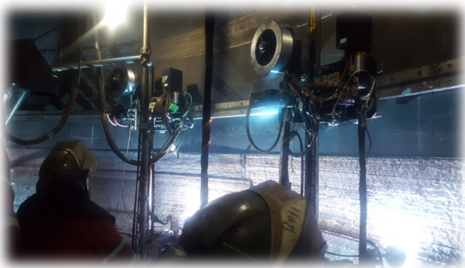
Figura: Soldando el Reforzamiento Internamente
