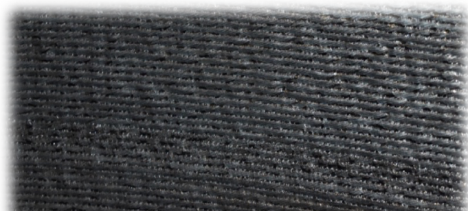
Figura: Acabado del Reforzamiento
