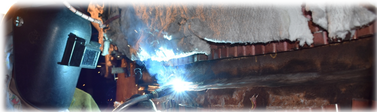
Figura: Soldando la banda de Weld Overlay Semiautomático
