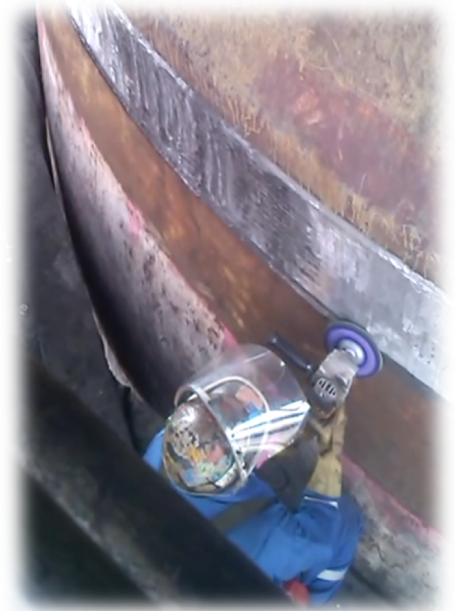
Figura: Acabado de la banda de Weld Overlay
